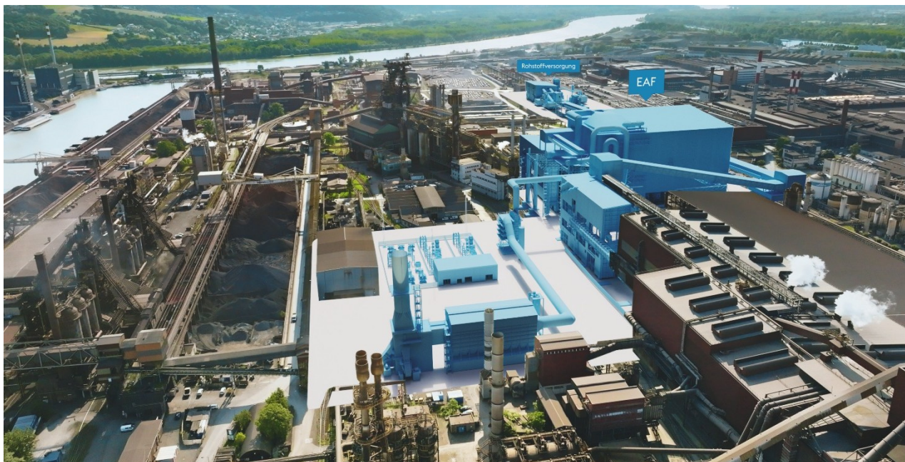
Umístění nové EOP ve voestalpine Linz
