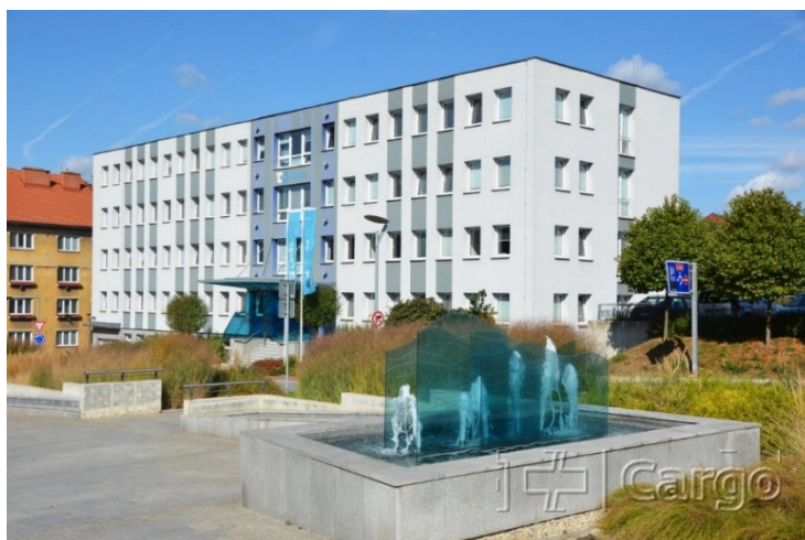
Budova Řízení provozu Česká Třebová
