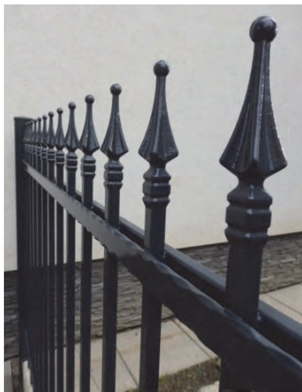
Obr. 37 Detail plotu vyrobeného z válcovaných profilů a s využitím zápustkového kování (foto spoluautor článku)
