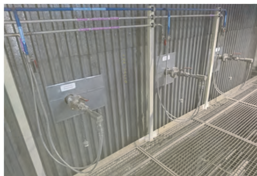
Obr. 3 Trysky systému SNCR
