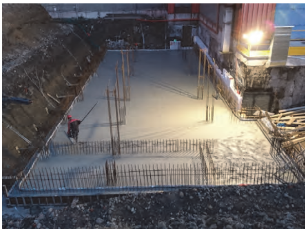
Energetika Třinec - betonáž základové desky
