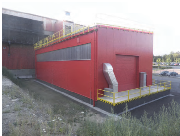
Energetika Třinec – finální stav rozvodny
