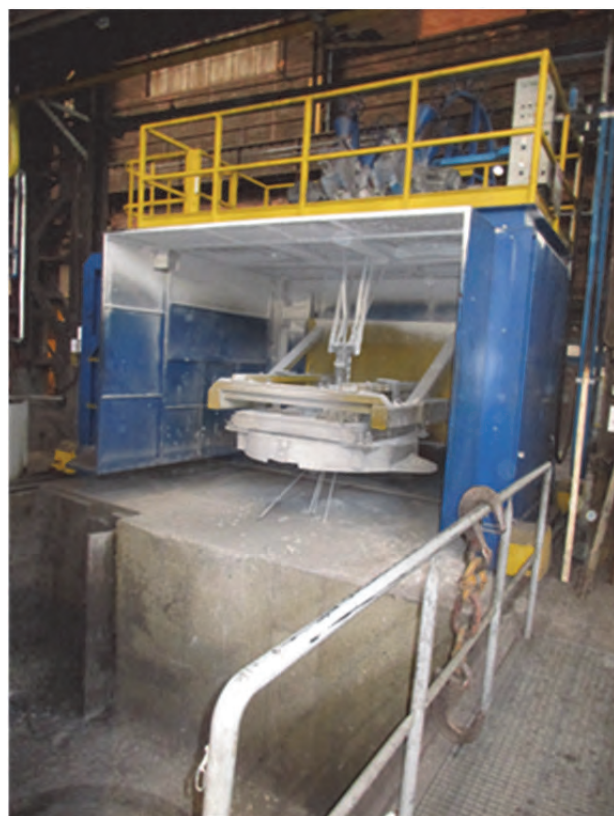
Obr. 4 Modifikační stanice TRF Fig. 4 Modifying station TRF
