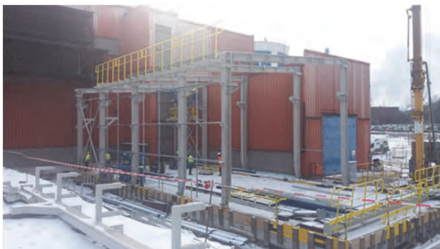
Energetika Třinec - montáž ocelové konstrukce
