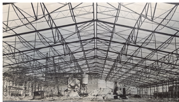
Obr. 2 Pohled do jedné z hal Nové šamotky v době výstavby, 1960/1961
