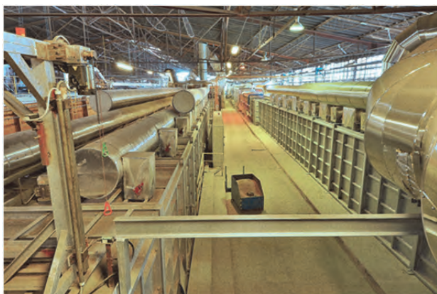
Obr. 4 Tunelové vypalovací pece, současný stav
