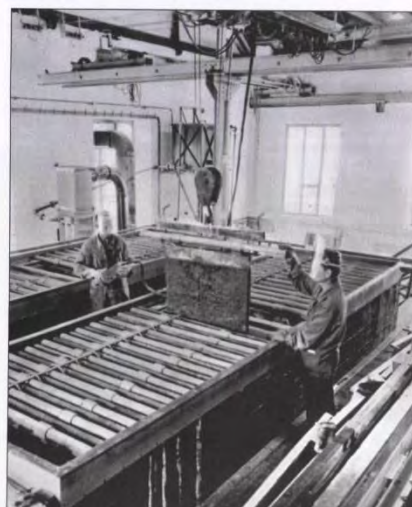
Obr. 2 Zrážacia elektrolyza zinku z druhotných surovín v Banskej Bystrici, 1968.
