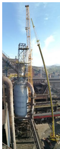
Dle 3D modelu zkonstruovaný prašník vysoké pece před montáží
