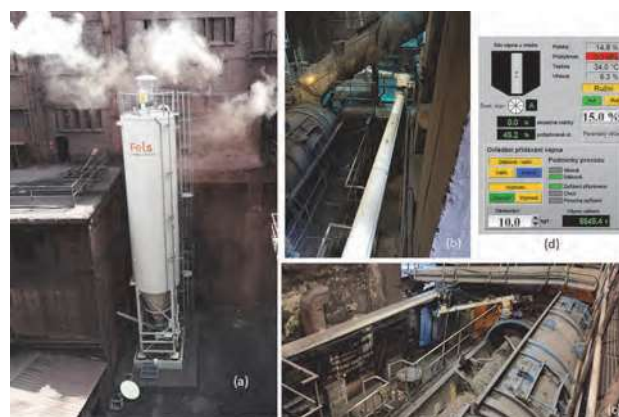
Obr. 1 Systém dávkování vápna do aglomerační směsi
