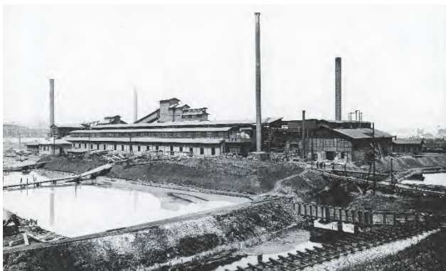
Obr. 3 Celkový pohled na měďárnu z roku 1913 [16]
