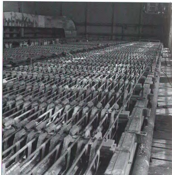
Obr. 4 Rafinačná elektrolýza medených anód v Kovohutách n. p., Krompachy, 1962
