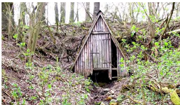
Obr. 14 Výtok vody z bývalé dědičné štoly v Jezdovicích, v současnosti již zasuté
