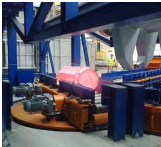
Obr. 1 Výstupní úsek karuselové ohřivací pece
