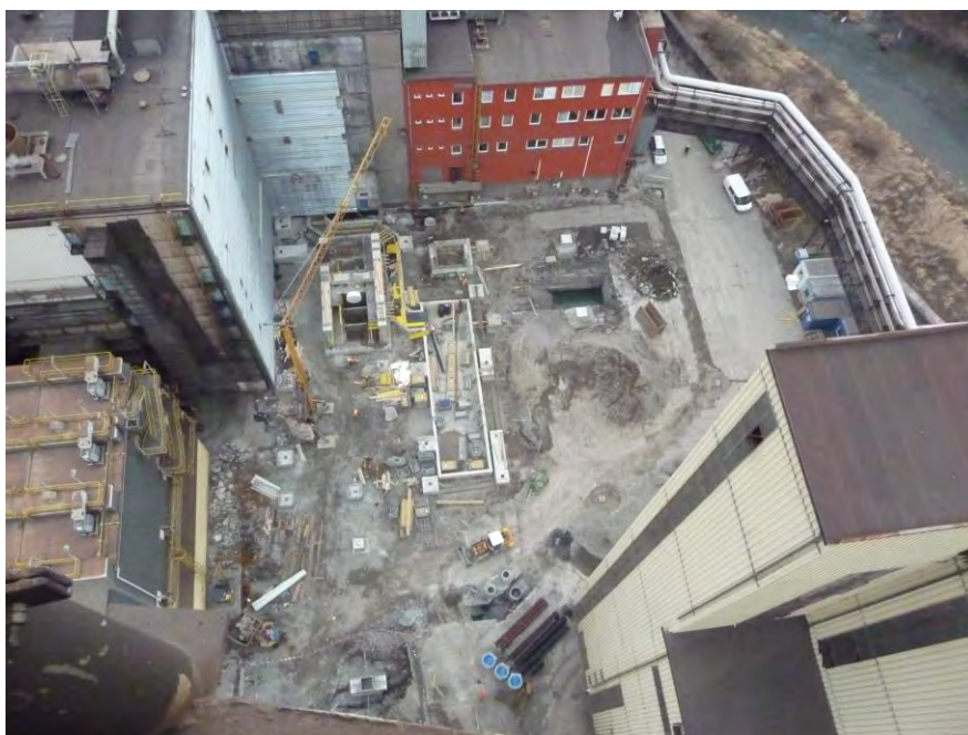
Obr.4 Pohled na staveniště v 2/2014 - rozpracovaná spodní stavba NK14
