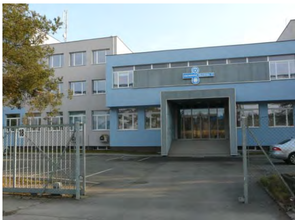
Obr. 1 Správní budova Sochorové válcovny
