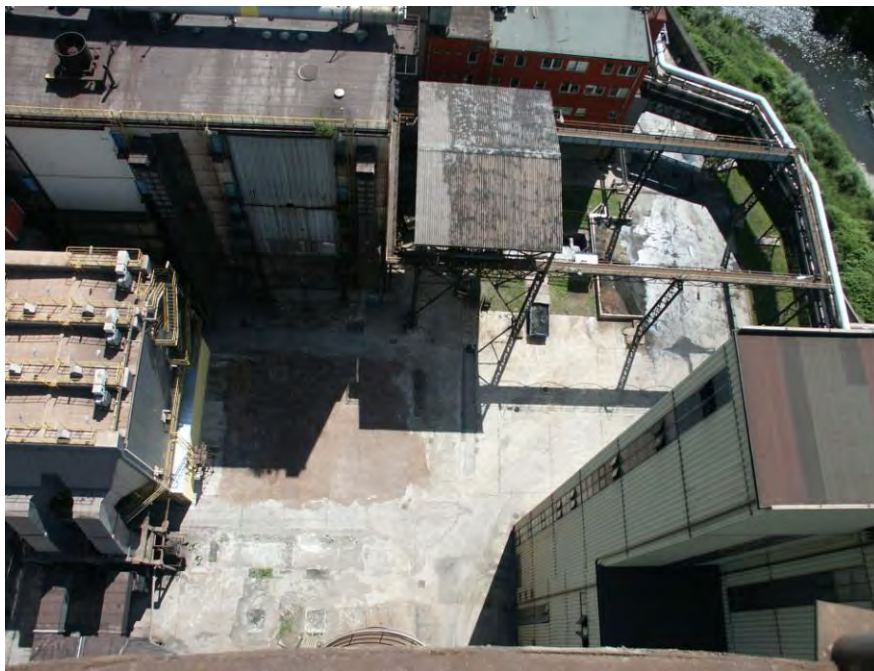
Obr.3 Pohled na staveniště NK14 před demolicí pláště staré kotelny
