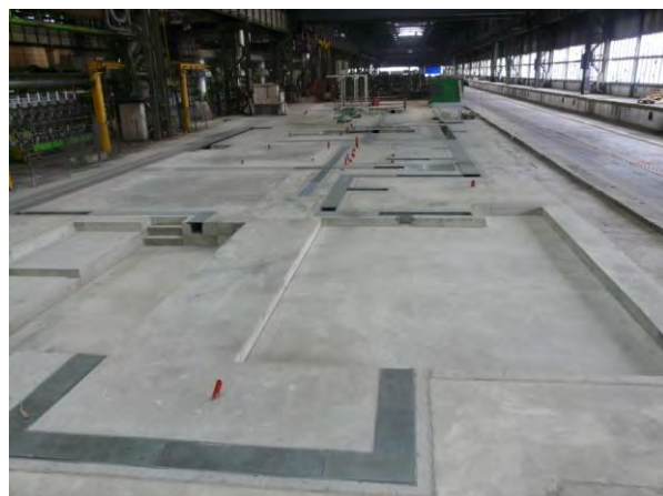
Obr. 3 Budující defektoskopická linka - prostor připraven pro montáž jednotlivých zařízení
