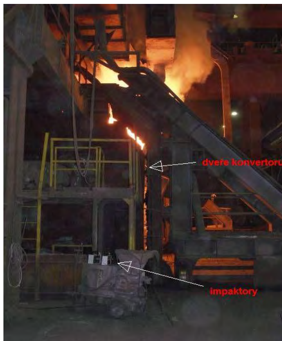
Obr. 10 Umístění odběrových impaktorů v konvertorové hale (odběrové místo č. 2)
