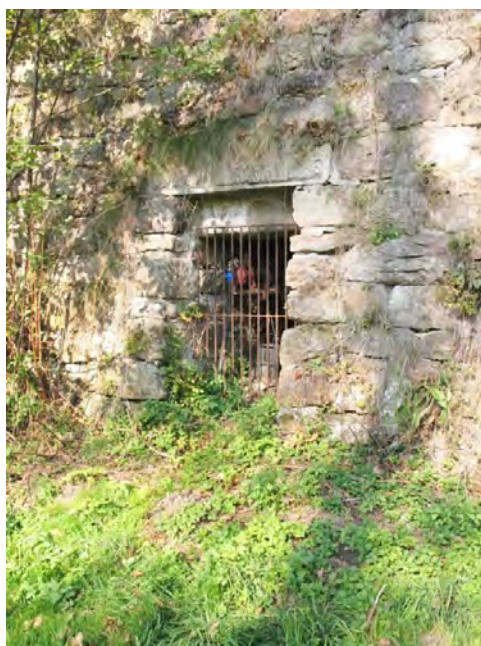
Obr. 8 Uzavřený vstup do štolu v kamenné stěně zrušeného železničního náspu (foto L. Stránský r. 2012). Fig. 8 Closed entry to the drift in a stone wall under the abolished railway track (photo L. Stránský 2012).
